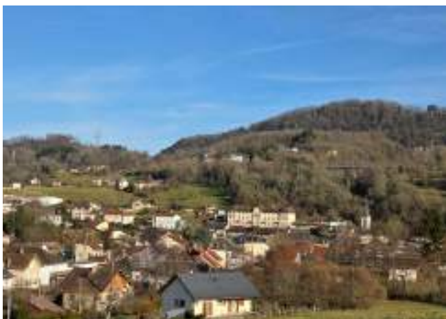
Vue aérienne, La Bridoire
